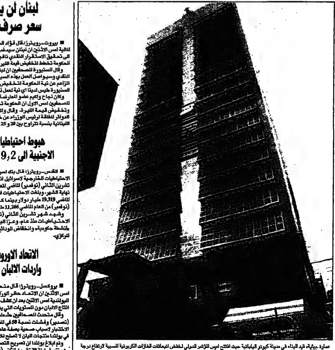
عمارة بيبوي، قيد البناء في مدينة كويت الجديدة حيث لنحت أسس للزائر الدولي لخفض التكاليف المالية الكبيرة لتسبب ارتفاع درجة حرارة الأرض. وتتمتع العمارة جزءا من مخططها من أشعة الشمس التي يتم امتصاصها من طريق خلايا شمسية مبطنة على نوافعها (روبيرت)
